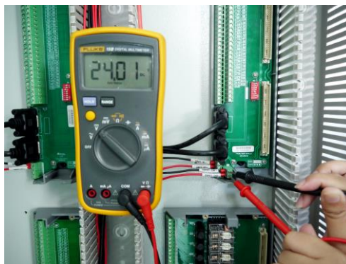
图8.4-4 直流配电电源检验示意图
